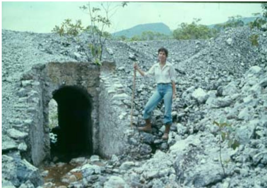
Figura 153. Fuente La Mina Alemana (Su- 16). Véase las obras de las viejas minas de azufre de fines del siglo XIX. Archivo C.D.I.G.N. Foto tomada por F. URBANI en 1985.
